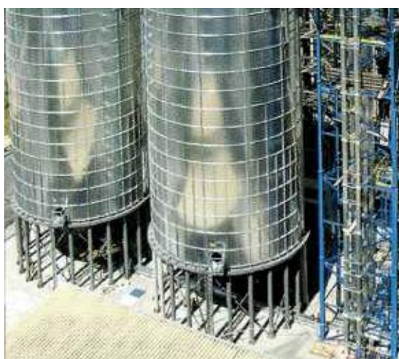
Рис.3. Силоси фірми «ARAJ» типу SPA
