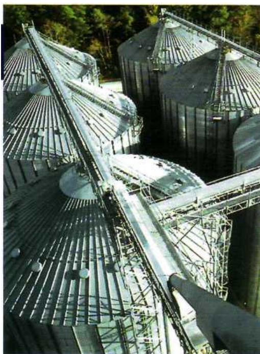
Рис.2. Загальний вигляд зерносховищ фірми «Brock»
