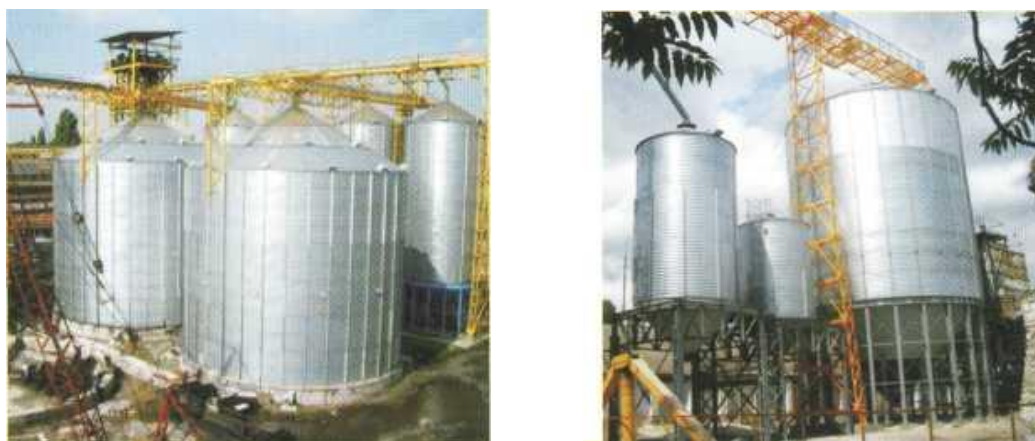
Рис.1. Загальний вид зерносховищ ВАТ «Карловській машинобудівний завод».
